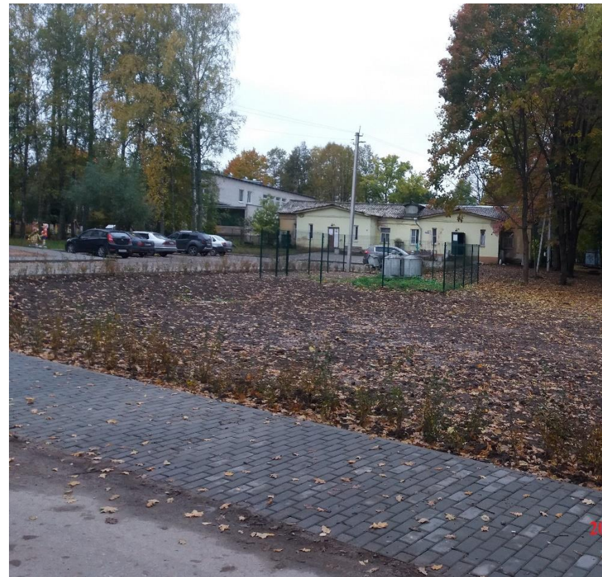
После проведения работ
