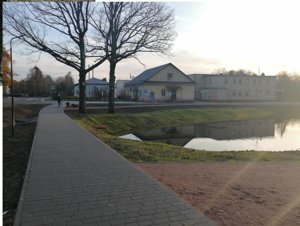
После проведения работ
