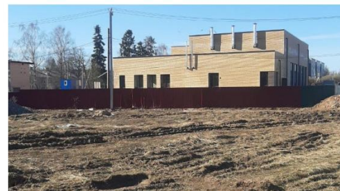
Неблагоустроенная территория на пути к строящемуся дому культуры
