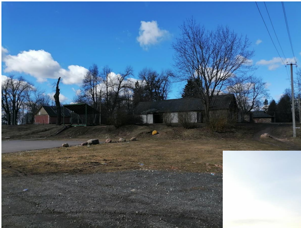
До проведения работ
