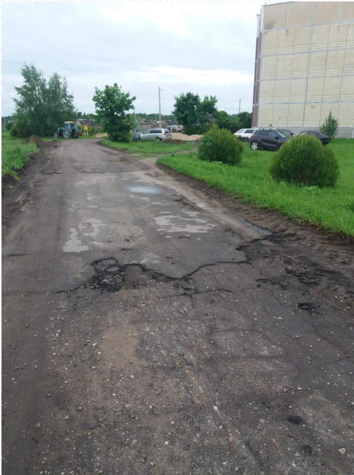
До проведения работ
