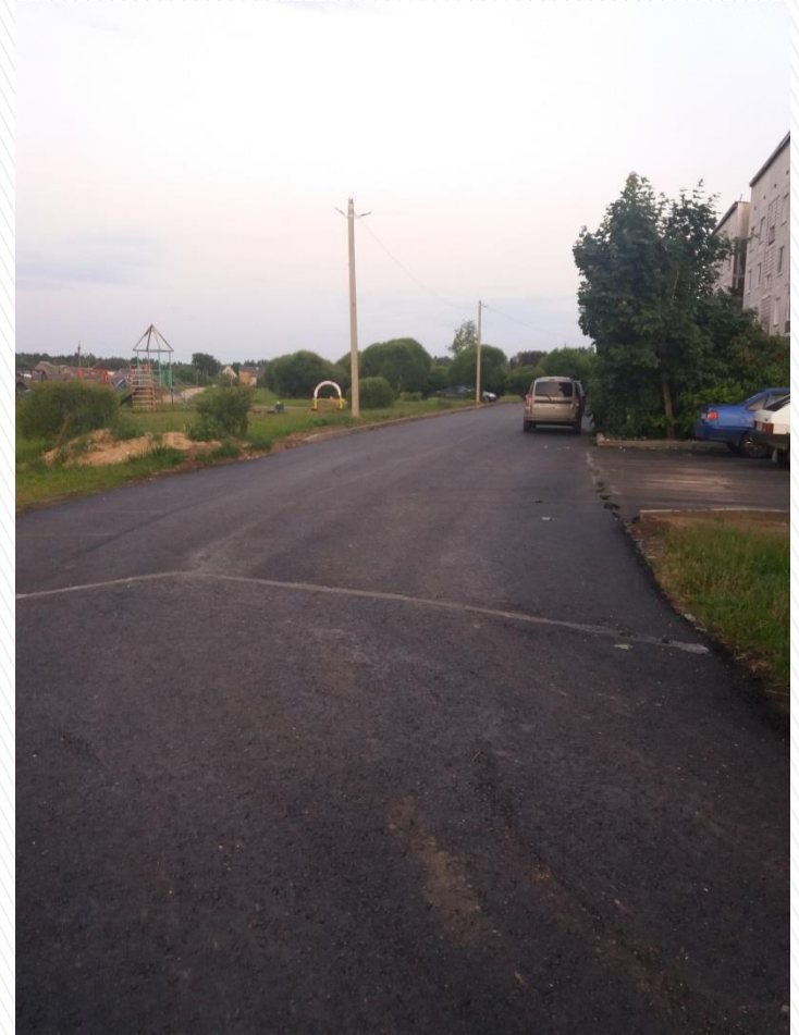
После проведения работ
