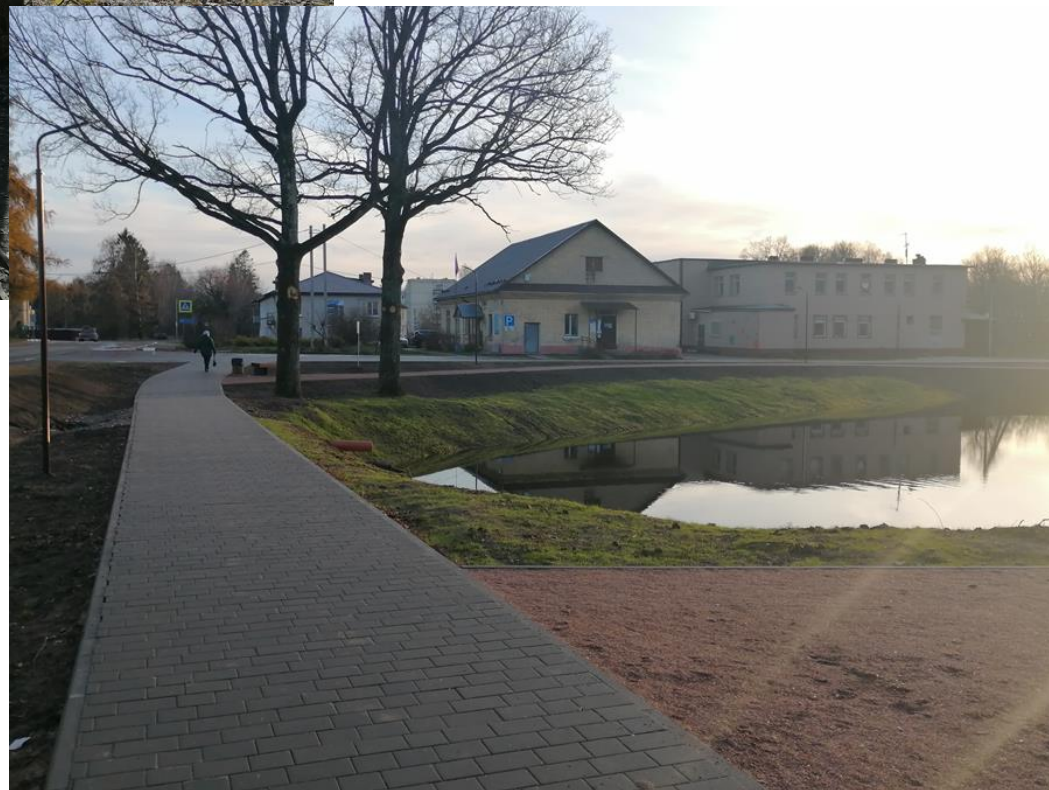
После проведения работ
