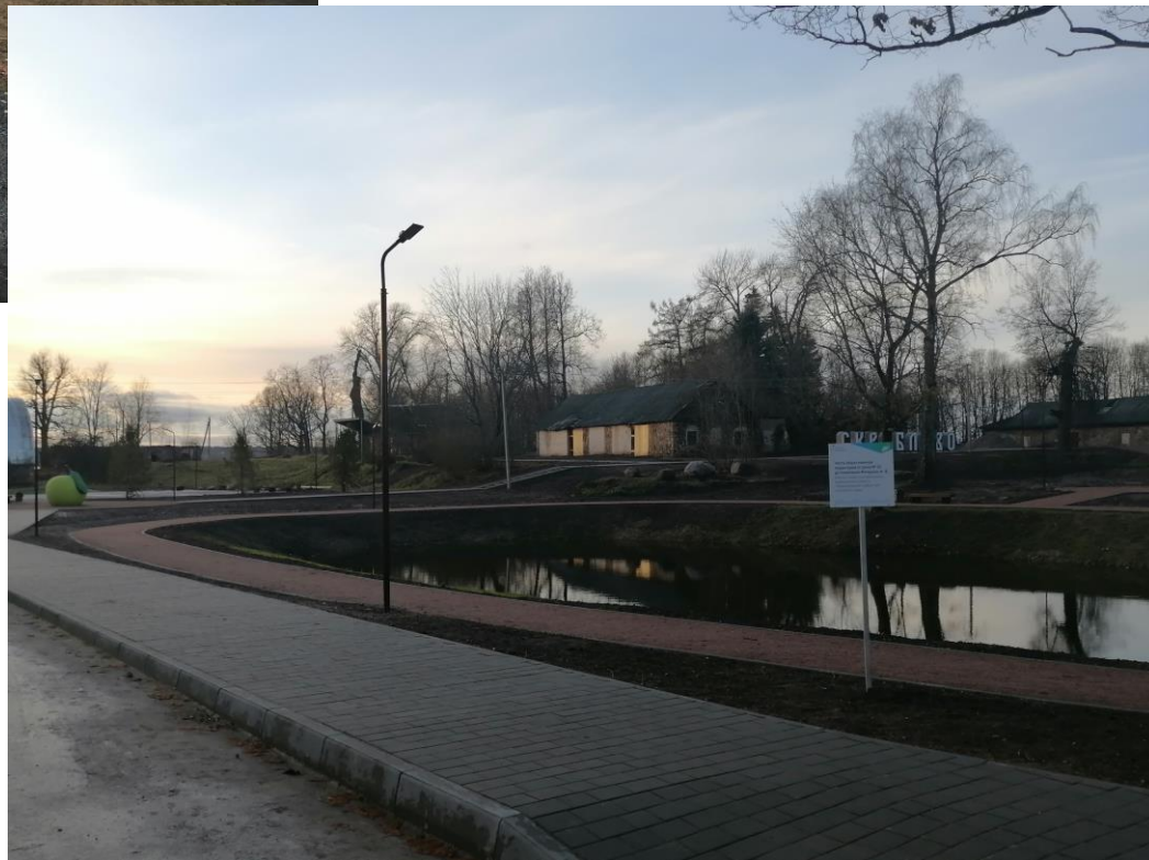
После проведения работ
